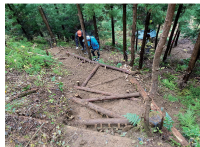
山の材料を用いる「近自然工法」で階段を施工
