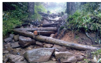
水の流れを考慮して丸太を斜めに配置
