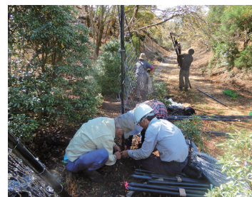
防鹿ネットの資材を運び入れ設置する
