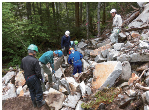
白出沢ルート崩壊箇所の現状復旧作業
