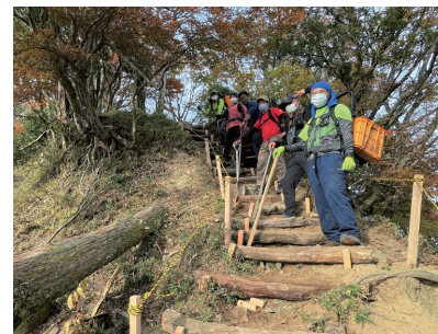
遠足尾根中腹の通行危険箇所整備完了後に
