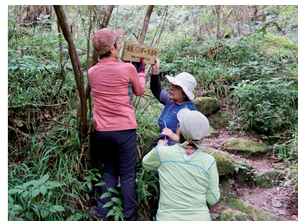
新しい道標設置作業の様子
